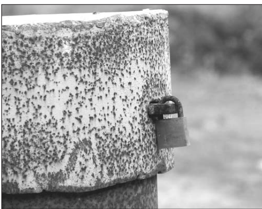
Uno dei pozzi della Bannata inspiegabilmente abbandonato
